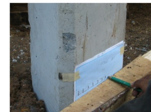
Final set dilakukan untuk menjamin bahwa tiang pancang sudah mencapai tanah keras
