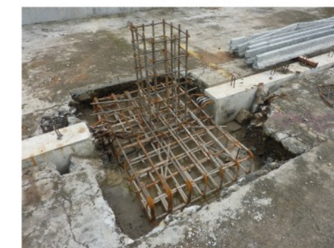
Rangka pile cap / poer & kolom
