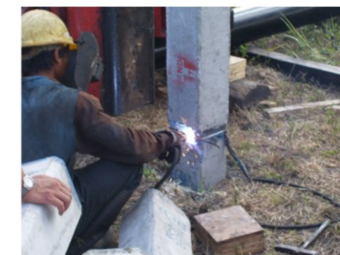
Tiang pancang disambung dengan cara dilas di antara kedua plat besi
