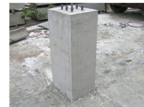
Hasil jadi pile cap / poer & kolom
