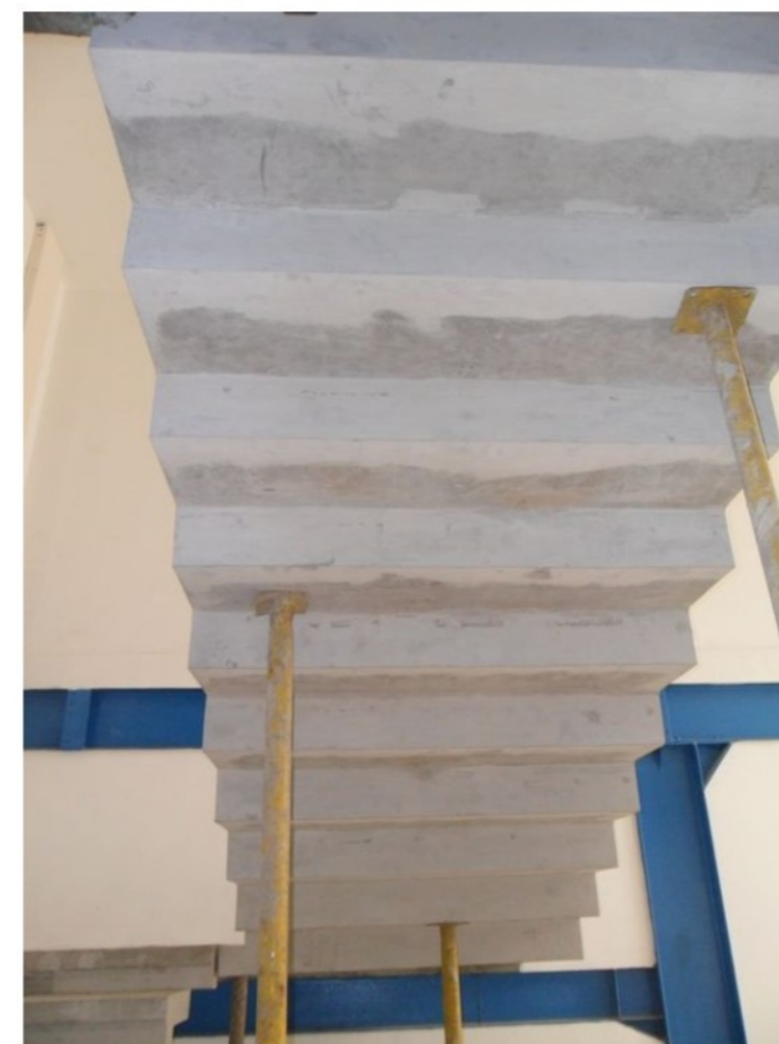
STEP STAIR Tangga precast melayang. Tidak memerlukan balok lagi. Sehingga memberi kesan keindahan.
