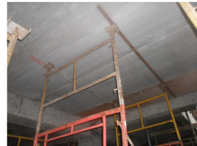
Saat pengecoran permukaan bawah, half slab harus disupport terlebih dahulu
