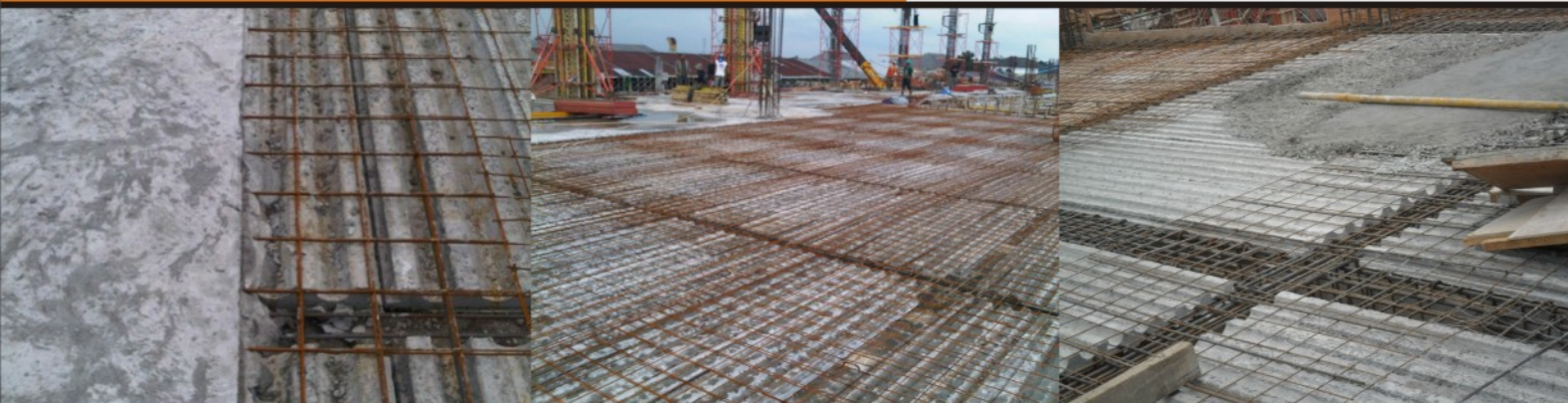
Lantai half slab pada saat sebelum dan sesudah dicor
