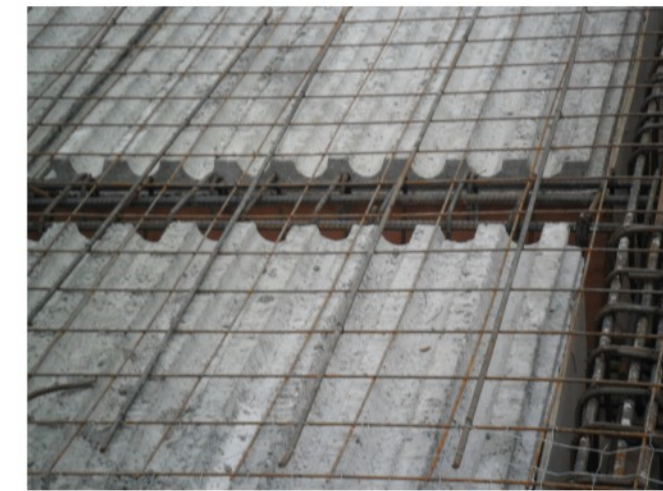
Penempatan wiremesh diatas half slab sebelum dicor
