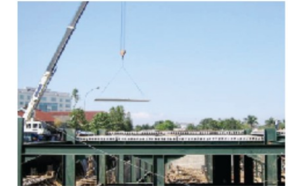
2. Dengan menggunakan Mobil Crane
