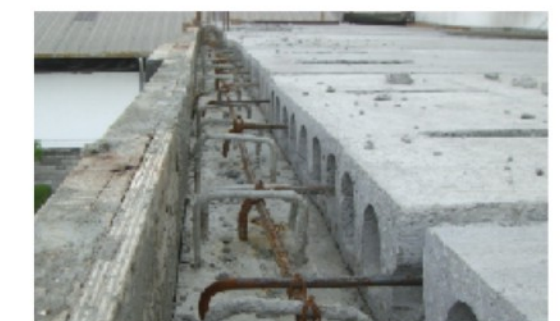
2. Di atas Struktur Beton
