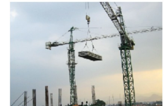
3. Dengan menggunakan Tower Crane
