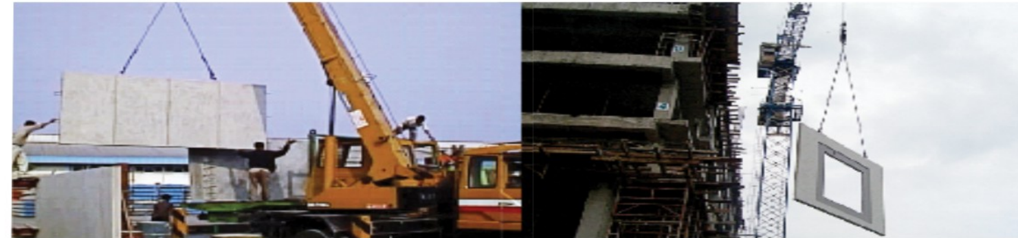
1. Pengangkatan menggunakan mobil crane
