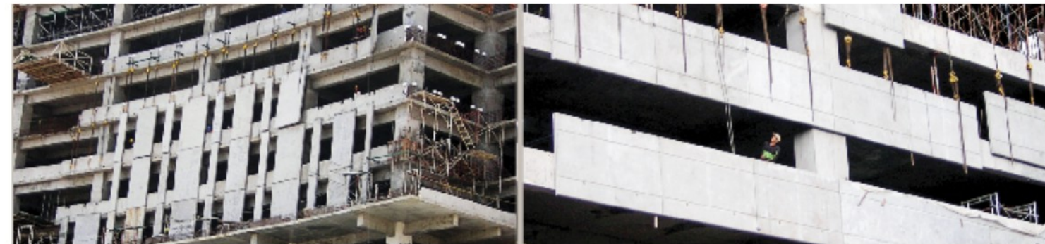
Tahap Setting Façade
